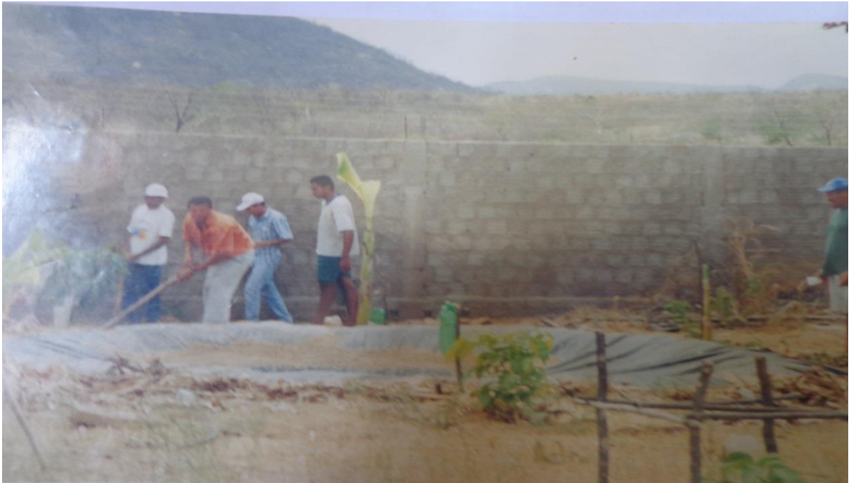
Foto 6: A construção do Mandalão
